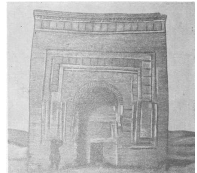
Рис. 46. Мавзолей Жузден. Главный фасад.
